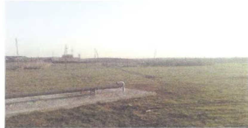
Сооружение «Обводнение отгонных пастбищ Республики Дагестан СПК «Кишинский» Дахадаевский район с водозабором из артезианской скважины № 05/2012»
